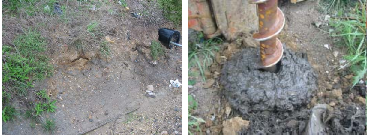
Abb. 3: Entwässerungsprobleme (Dep. Heinde)
