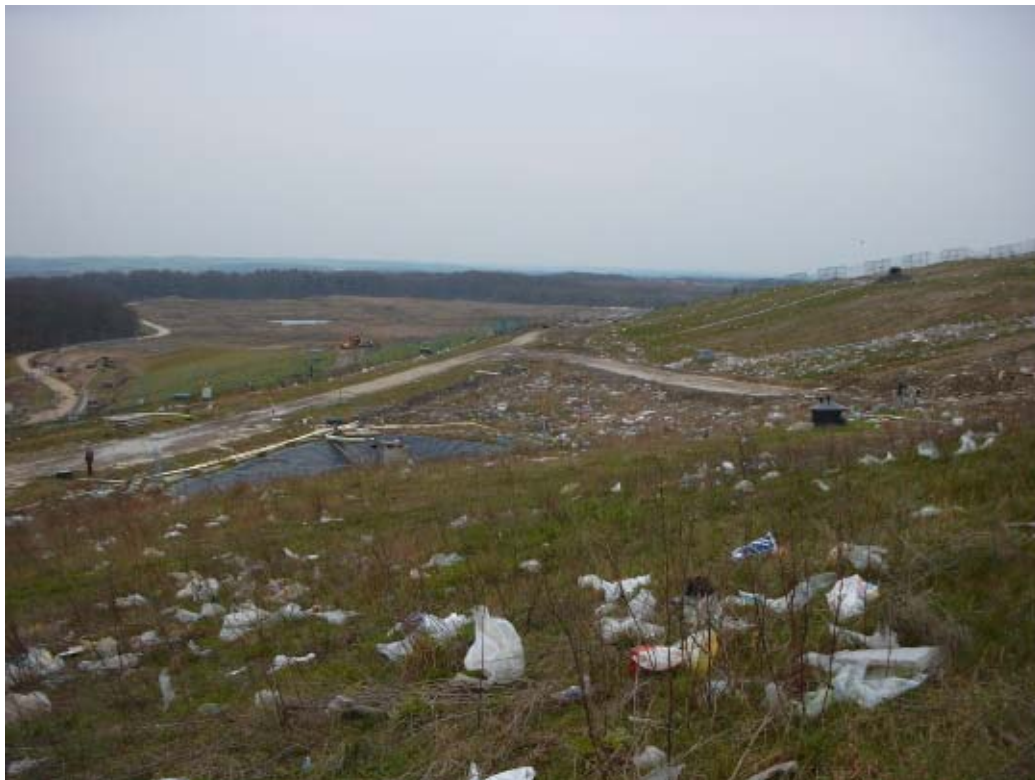
Abb. 8: Ostböschung Deponie Ihlenberg – Einbuchtung
